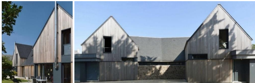
Exemple de maisons jumelles, SABA Architectes, Perros-Guirrec
