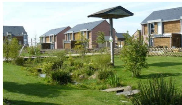
Espace paysager et de gestion des eaux pluviales Ecoquartier des arondes, Roncherolles-sur-le-vivier
