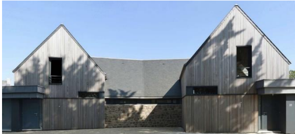
Exemple de maisons jumelles, SABA Architectes, Perros-Guirrec
