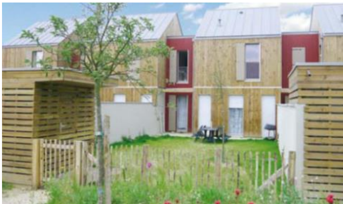
Façade de logements individuelles mitoyens en bois
