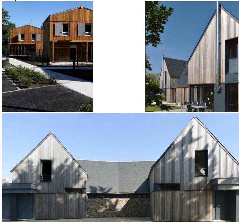
Exemple de maisons jumelles, SABA Architectes, Perros-Guirec
