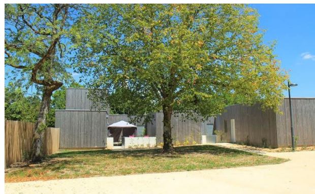
Placette structurée par les maisons Le Pellerin (44), Agence ROULLEAU architectes
