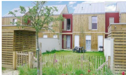
Façade de logements individuelles mitoyens en bois
