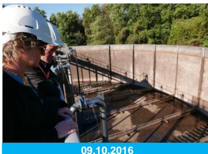
09.10.2016 Visite de la station d'épuration des eaux usées de Choisy à l'occasion du renouvellement des diffuseurs
