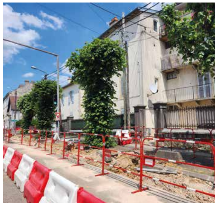
● L'avenue de Northwich lors des travaux d'enfouissement de réseaux secs.
