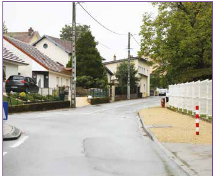
● Rue Casimir-Persan : réfection des trottoirs.
