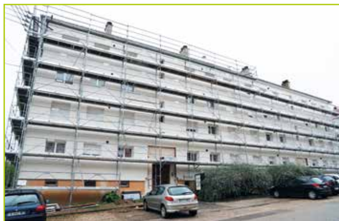
• Les bâtiments en cours de transformation.
