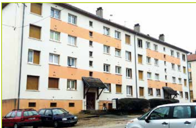
• Les bâtiments avant rénovation.
